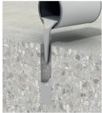
Mix & pour grout resin into hole.
