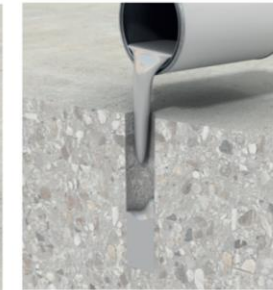
Mix & pour grout resin into hole.
