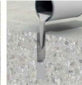
Mix & pour grout resin into hole.
